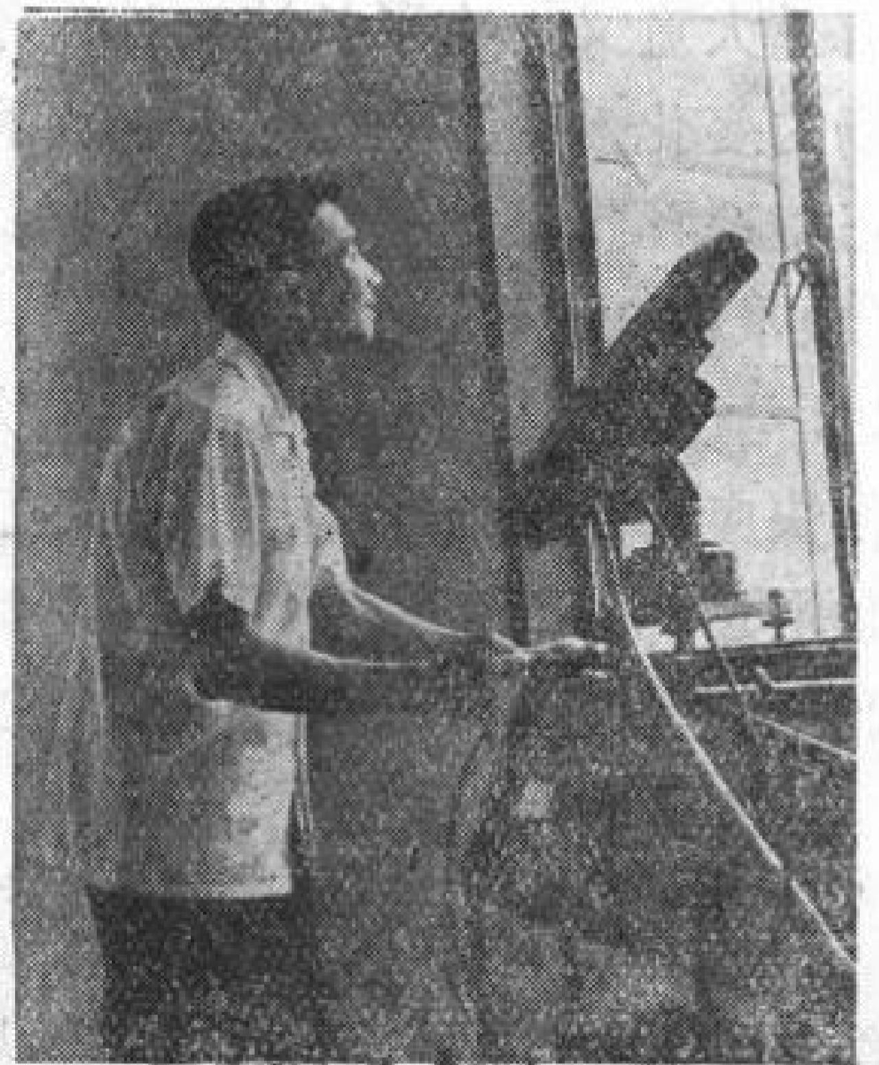
图 2-12 激光测云雷达
